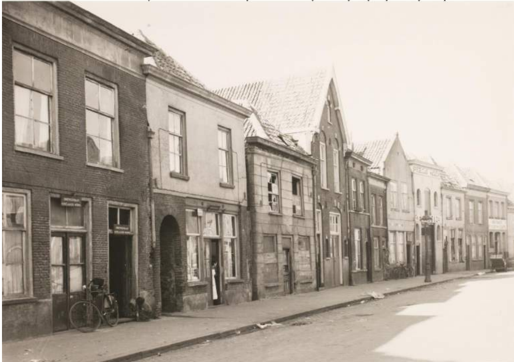
Foto uit 1955 van de Beurdsestraat, enkele jaren voor de sloop. Boven de foto staan de perceelsnummers. Perceel 6 is niet meer bewoond, maar staat in 1957 op de nominatie om eventueel te verbeteren. Perceel 7 en 8 zijn onbewoonbaar verklaard, maar nog niet onbewoond (bron: Stadsarchief 's-Hertogenbosch, inv.nr. 0021696).
